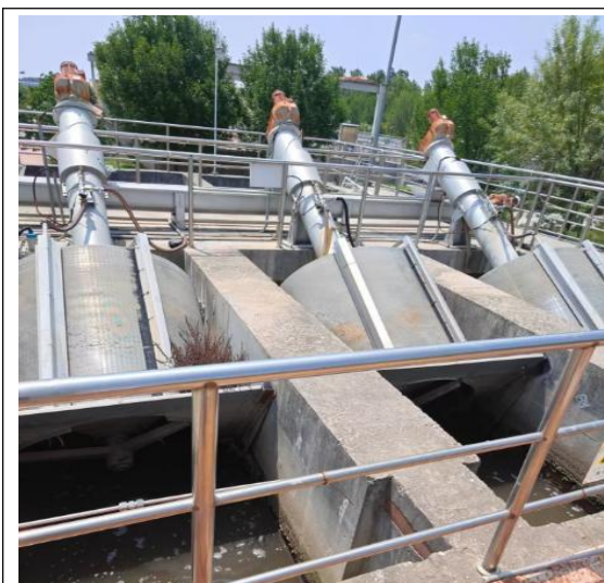
旋流固液分离装置
