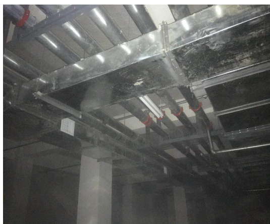
图 5 地下车库配套通风换气系统
