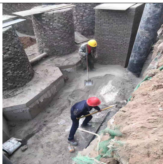
图 2 中水回用管道铺设情况
