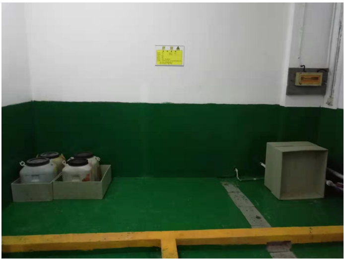
废液暂存区，分区存放、桶装、托盘、防腐、围堰
