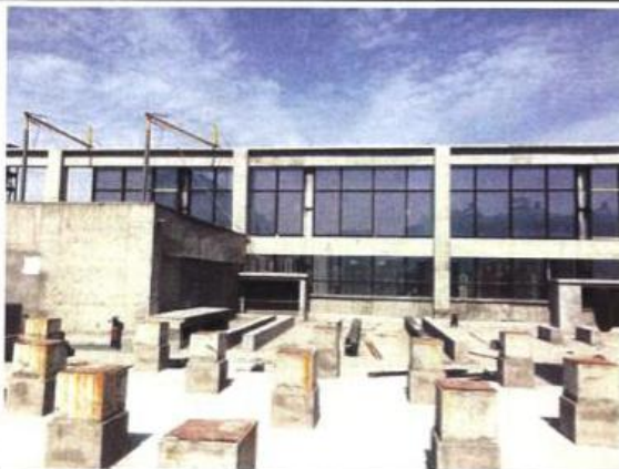
A座楼顶隔声玻璃幕墙
