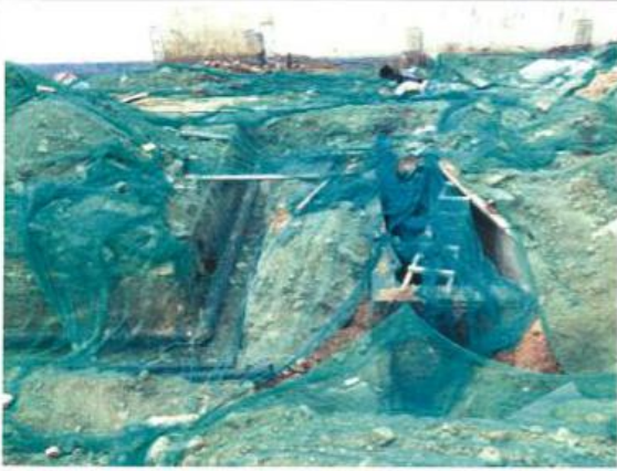
中水管道铺设
