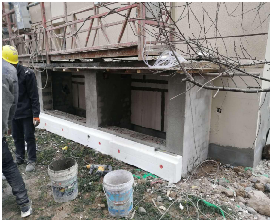
图 6 废气地面排口
