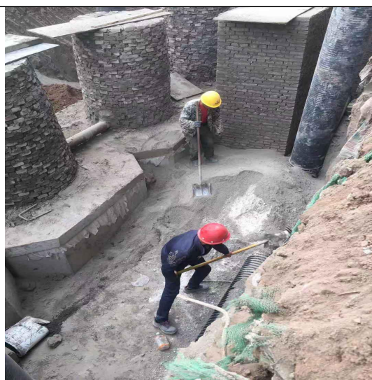
图 2 中水回用管道铺设情况
