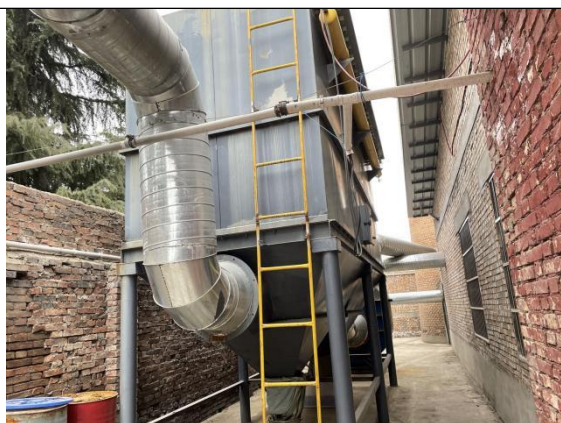
配料、炼胶工序布袋式除尘器+活性炭吸附装置 +UV 光氧
