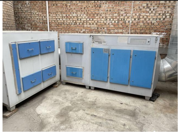
涂胶、喷漆工序过滤棉+活性炭+UV 光氧设备
