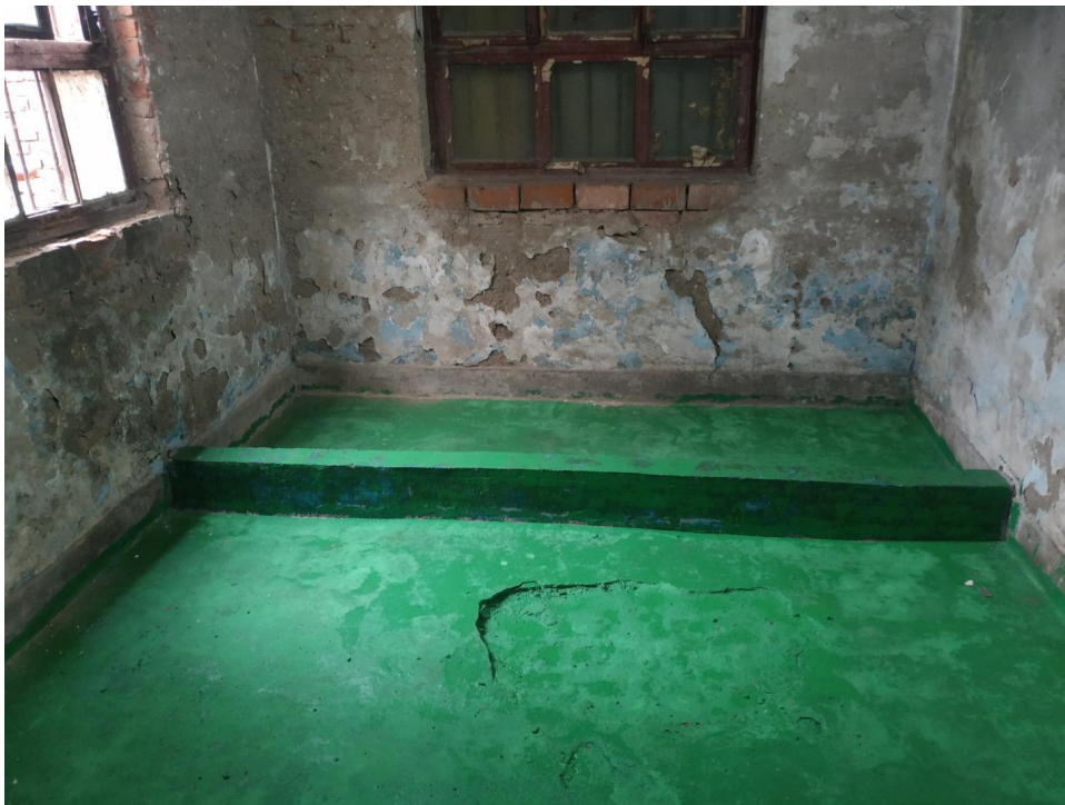
危废间防渗、防泄漏、分区
