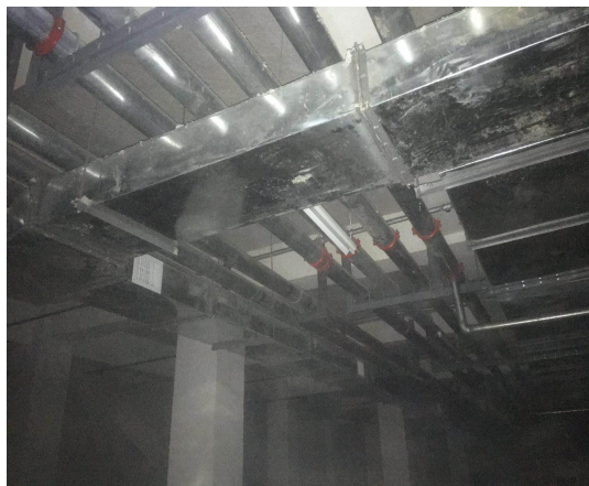
图 5 地下车库配套通风换气系统
