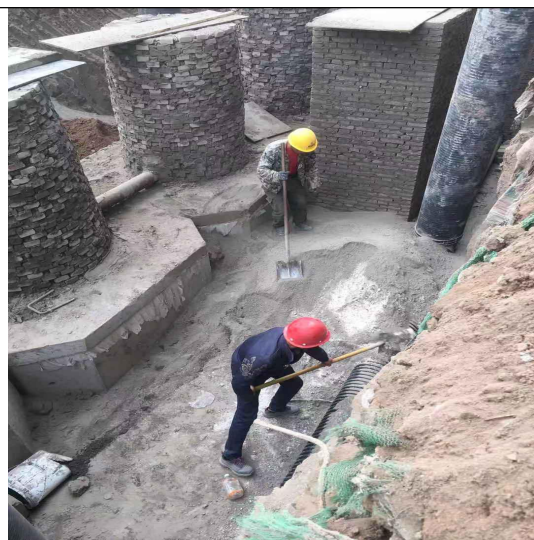
图 2 中水回用管道铺设情况
